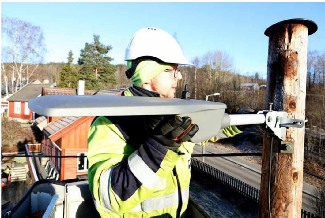
Utvendig montert antenne på toppen av armaturen. Det er viktig at LED-armaturer monteres helt rett – bruk vater!
