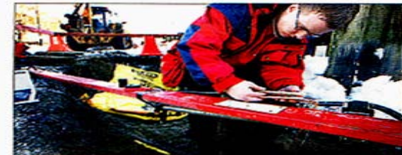
Kabelbrudd. Telemonter Glenn Paulsen (22) måtte skjote kabele som ble ødelagt i Lillevål Hageby i går morges da et entreprenørfirma skulle reparere en annen kabel.
